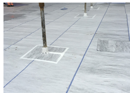
Tætning af detalje med HyDra Swelling Paste
