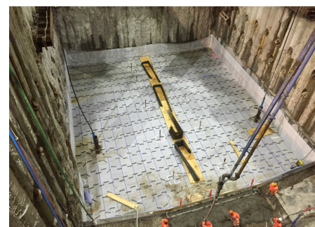
Færdig udlagt membran inden støbning
